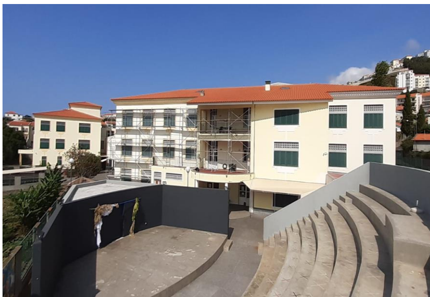
Figura 16 - Edifício B da Escola do Caniço
